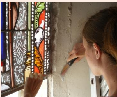
C.Gontel : Εργασίες σε εξέλιξη
