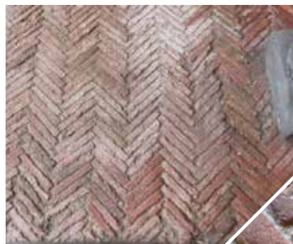
SOTTO_15-17. Pavimentazione in mattoni posati a coltello prima e dopo i lavori; dettaglio.
