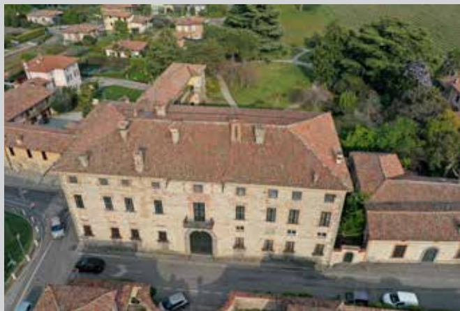
3. Vista della facciata su strada da drone..
