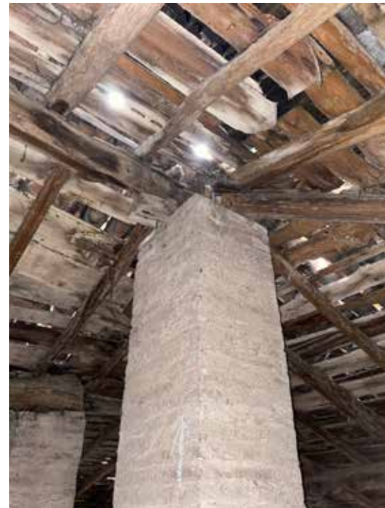
5 e 6. Stato di fatto prima dei lavori.
